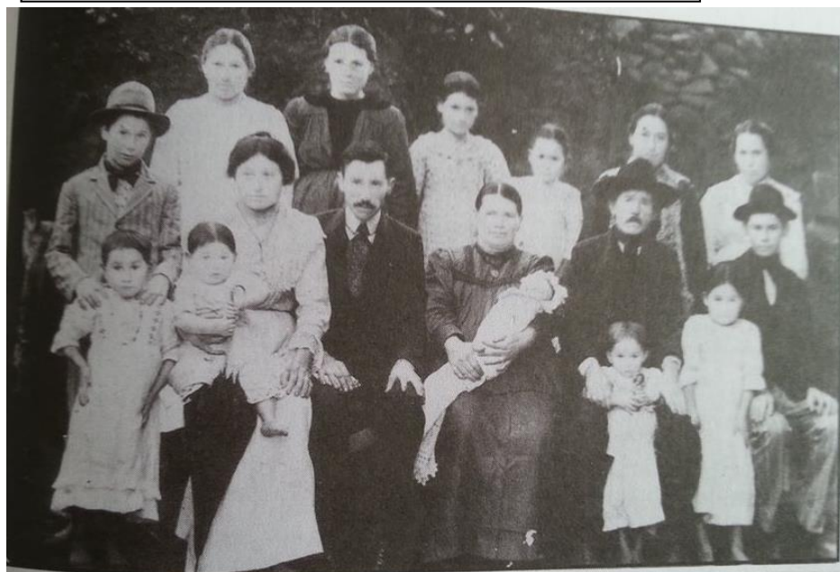
Foto 20 - Domingos Petrolli e Pierina Locatelli e filhos
