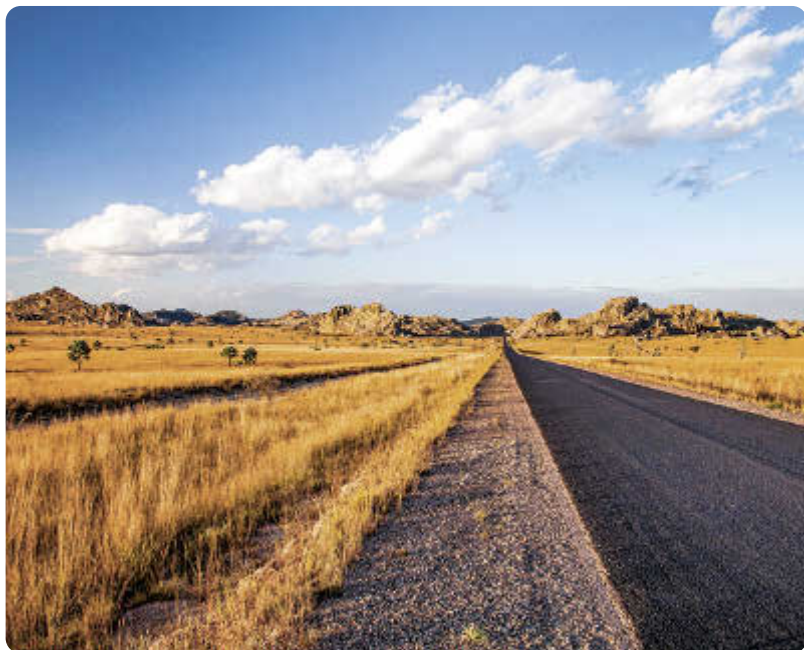
Sur la RN7, avec l'Isalo en ligne de mire
