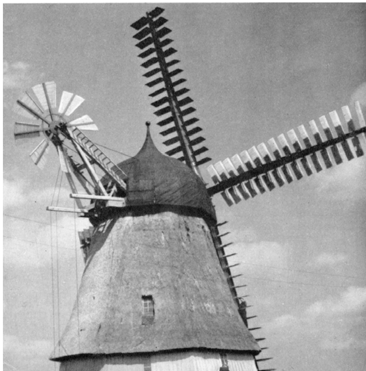
Figure 1.7 – Exemple de moulin à orientation par moulinet, tiré de la revue Science et Avenir , n° 30, août 1949 (collection M. Rapin)
