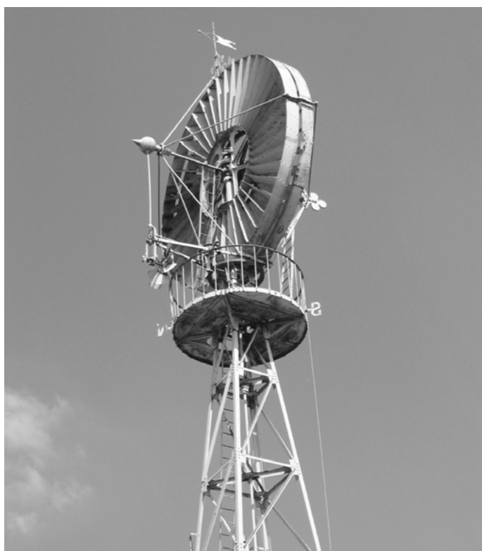
Figure 1.10 – Epuisay : Bollée modèle n° 3 de 1911 (diamètre 5 m) fabriquée par Lebert avec une tour de conception classique (crédit photo : M. Rapin)
