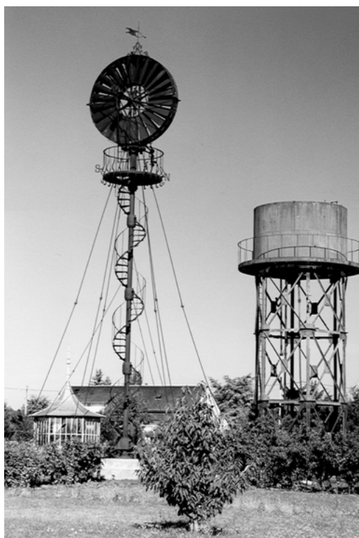
Figure 1.9 – St Martin d'Ocre : Bollée modèle n° 2 de 1893 (diamètre 3,5 m) avec le réservoir d'eau à proximité (crédit photo : M. Rapin)
