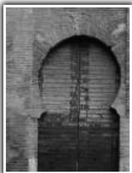
Puerta de la Dar al-Imara
