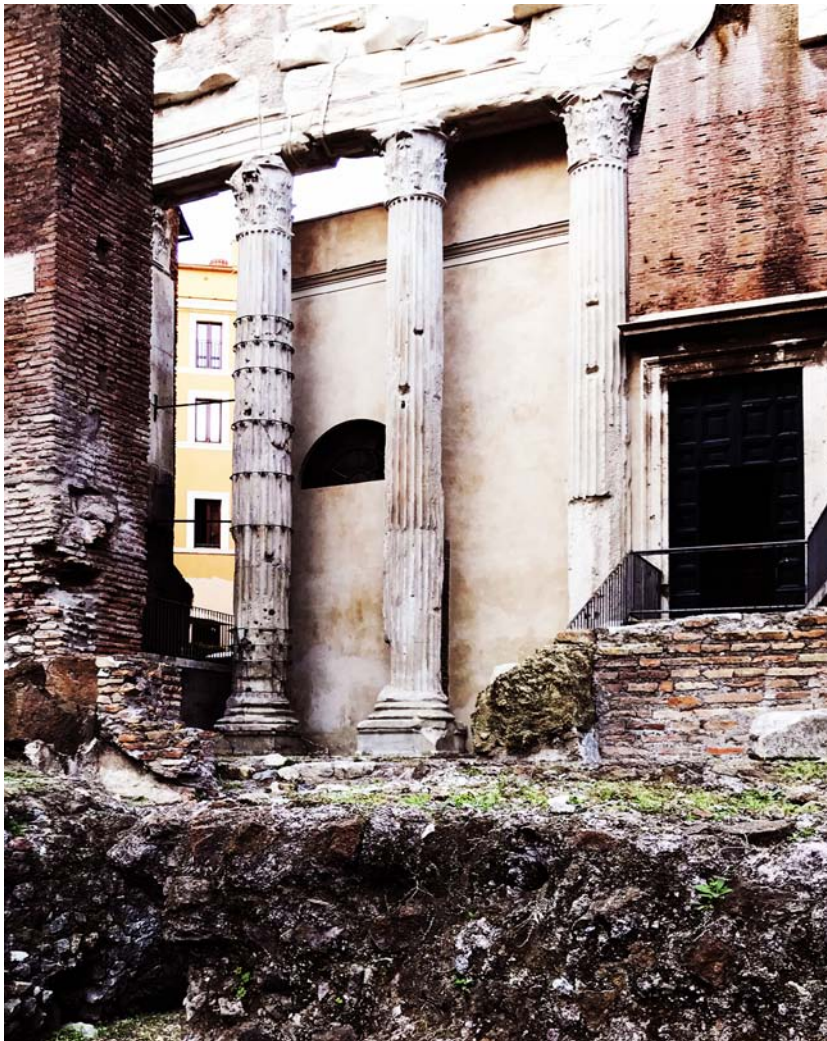
Fig. 1 - Ingresso della Chiesa di S. Angelo in Pescheria. Entrance of the Church of S. Angelo in Pescheria.
