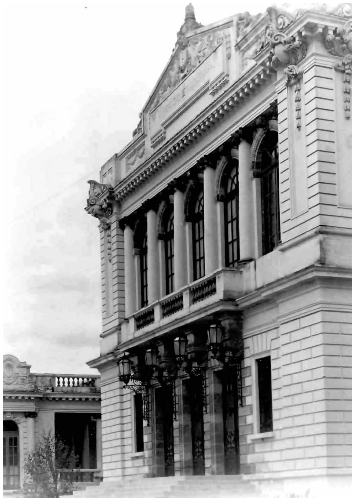
Figura 2. Fachada sur del edificio ubicada en la calle López Cotilla.
