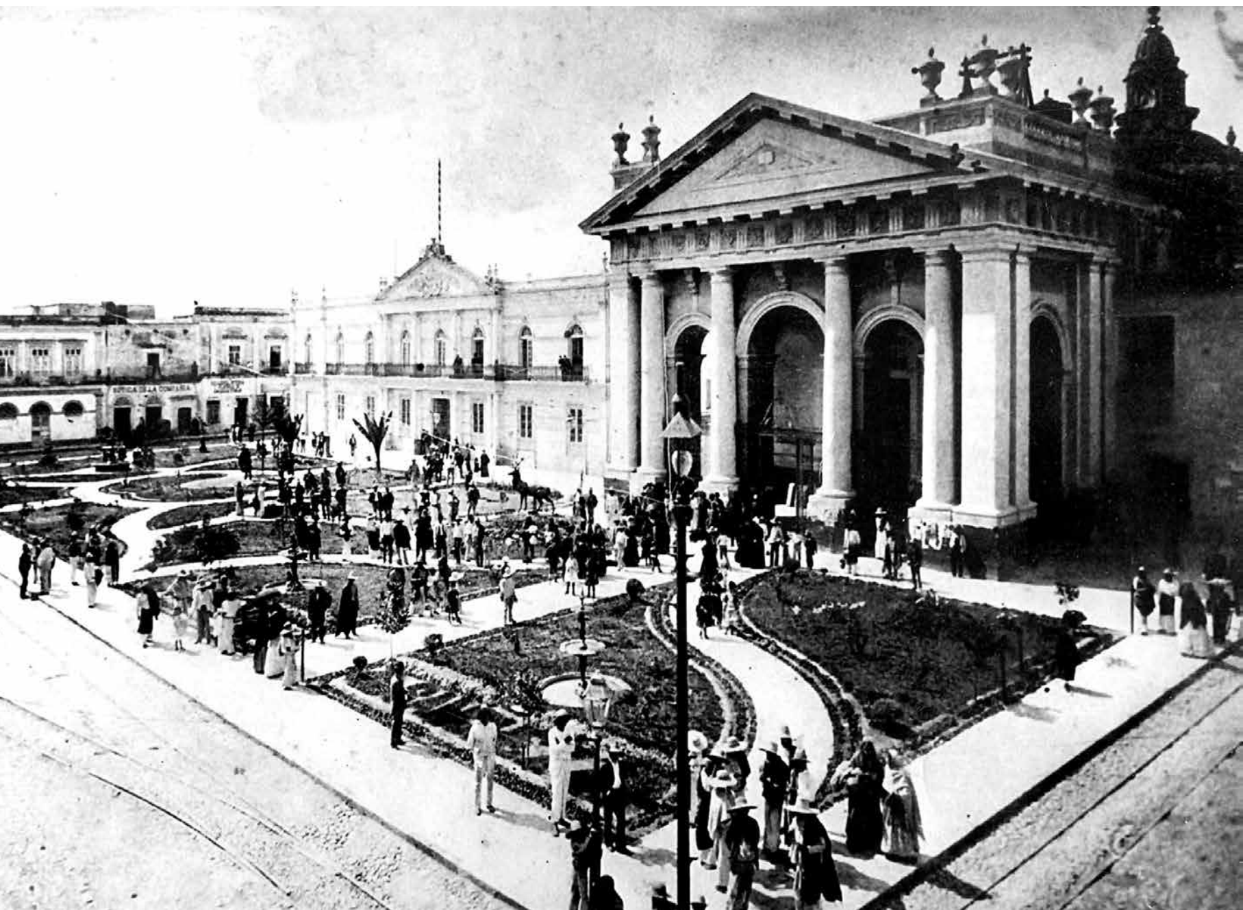
Figura 3. Plaza del exclaustro de Santo Tomás, donde fue fundada la Real Universidad de Guadalajara en 1792 y la Universidad de Guadalajara en 1925. El edificio también funcionó como Congreso del Estado y, más adelante, oficinas de Telégrafos.
