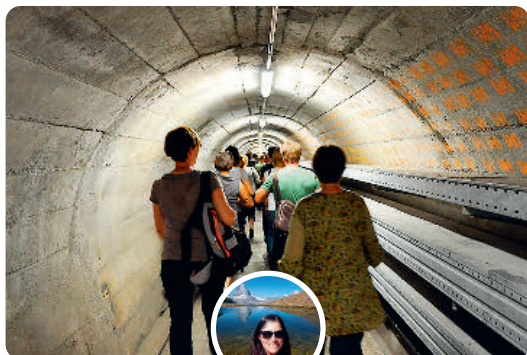
VEREN UNTERIRDSCH UBERAL EBEN, WWW.UNTERIRDSCH-UEBERAL.EBEN.CH
