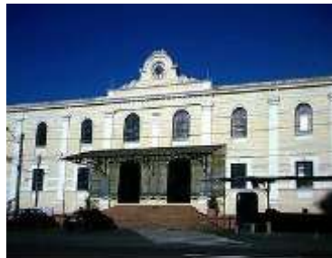
Estação de São Carlos
